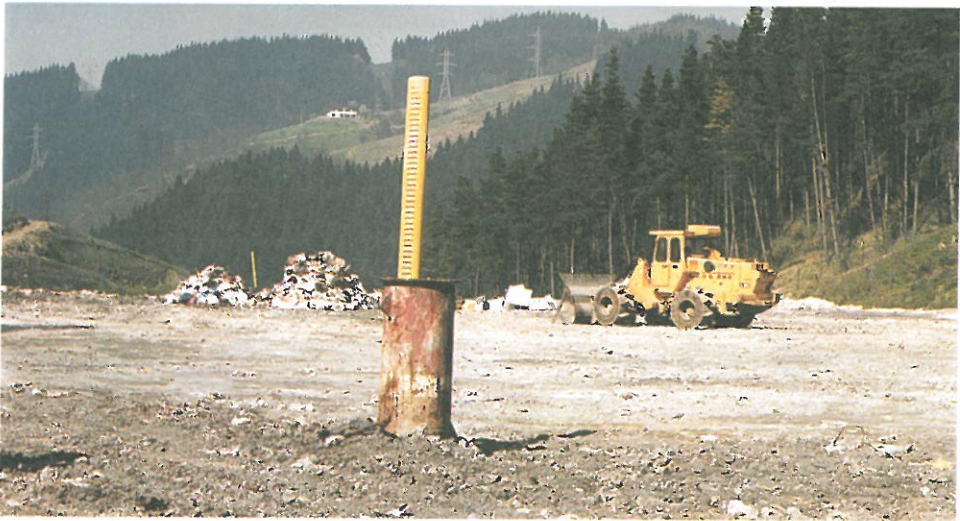
Trinkogailua zaborrak zabaltzen eta trinkotzen.
